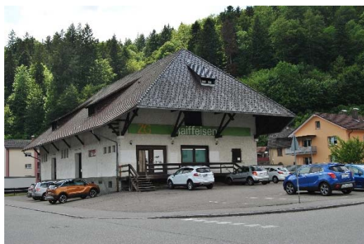
ZG Raiffeisen Lager
