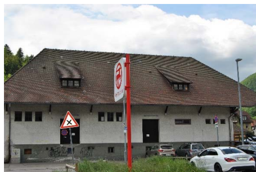
ZG Raiffeisen Lager
